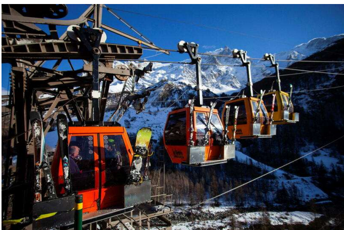
Construit dans les années 1970, le téléphérique de La Grave-La Meije, aux cabines d'un autre temps, relie le village à 1 400 mètres d'altitude aux hauteurs glaciaires à plus de 3 200 mètres. © ANDBZ / ANDBZ/ABACA
