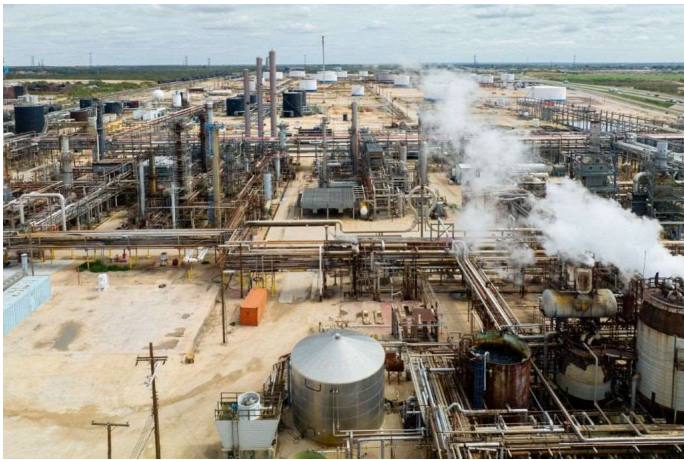
La raffinerie de Big Spring vue le 04 octobre 2023 à Big Spring, Texas.
