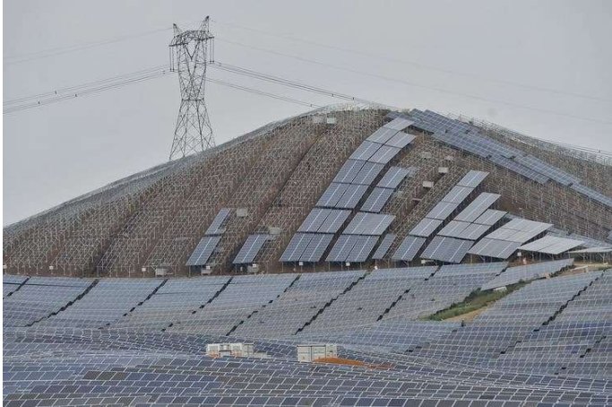
Bau einer Photovoltaikanlage in der chinesischen Provinz Anhui, 2014. Jianan Yu / Reuters
