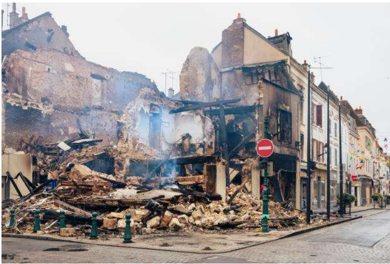
Un bâtiment a été incendié et a fini par s'effondrer, dans la nuit du 29 au 30 juin, à Montargis (Loiret), le 1er juillet 2023. CLÉMENCE LOSFELD POUR « LE MONDE »
