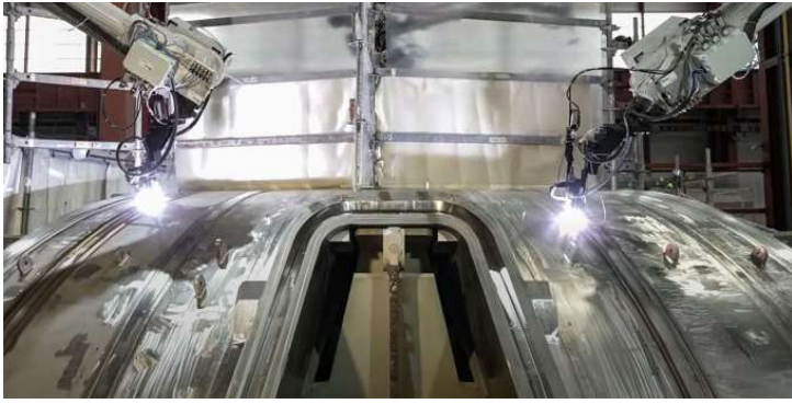
Roboter verschweißen präzise Bauteile des Tokamaks ITER. Für die Segmente der Vakuumkammer ist das nicht ohne weiteres möglich. :Bild: ENSA
