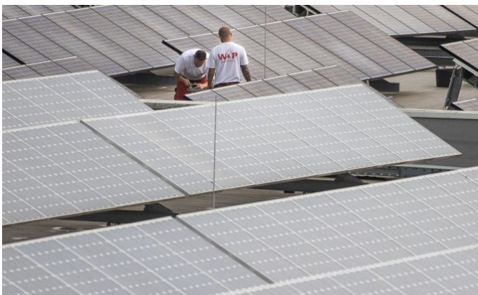
Arbeiter zwischen Paneelen einer Photovoltaikanlage in Frankfurt :Bild: Lucas Bäuml
