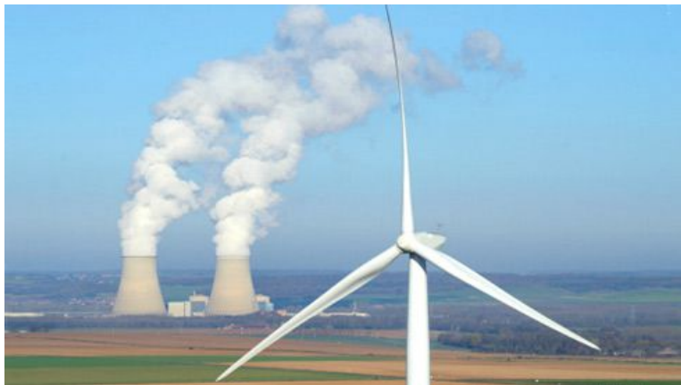
A nuclear power station in Nogent sur Seine, France
