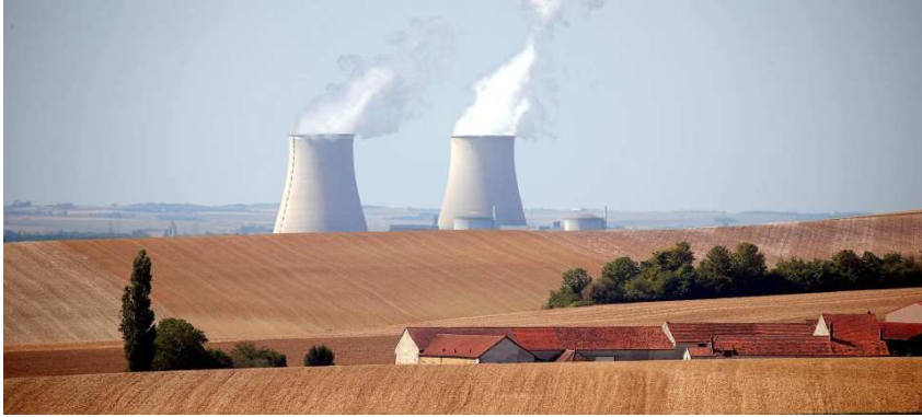
Das Atomkraftwerk in Nogent-sur-Seine Bild: Reuters
