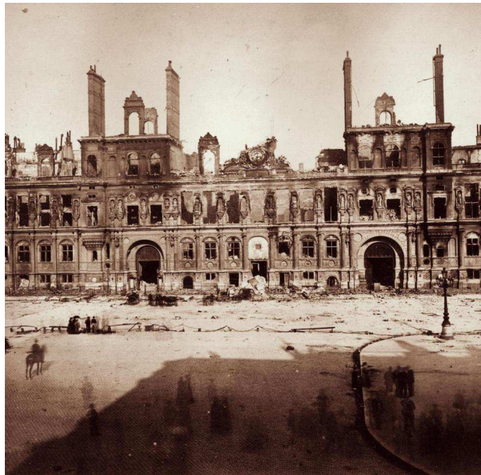
Das Pariser Rathaus war eine ausgebrannte Ruine
